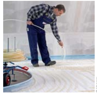
Uponor: Verlegung Klettsystem
